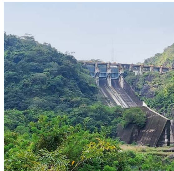
Barragem e vertedouro de Malpaso
