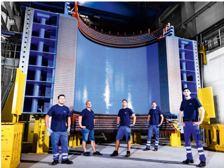
Em estreita colaboração com o cliente, a equipe de geradores da ANDRITZ instalou a unidade de motor-gerador resfriado a ar B09 em 2021.
