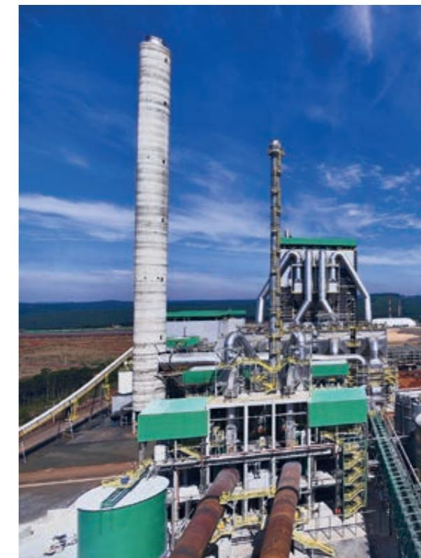
◀ 白液站有两台窑（每台能力650吨/天）。苛化站设计能力16,000立方/天。▶
