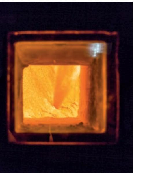
▲ 锅炉内部：液体喷入到炉膛，使用蒸汽雾化。
