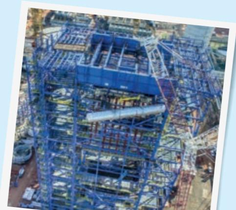
▲ Fibria's Horizonte 2个建设现场, 正在安置美洲最大回收锅炉的蒸汽鼓。鼓重200吨, 被吊起在70米高空中(详查本期第25页文章)
